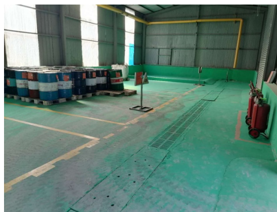
危废暂存库②内部
