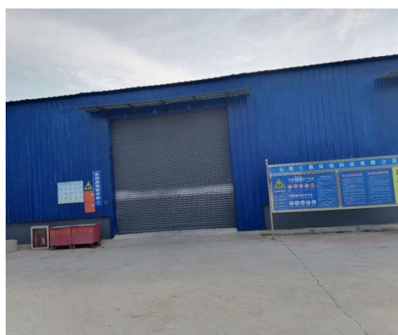
危废暂存库②
