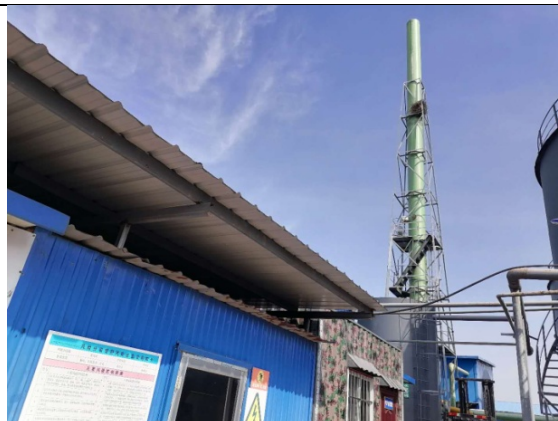
25m 高排气筒 (依托日照锦昌固体废物处置有限公司)
